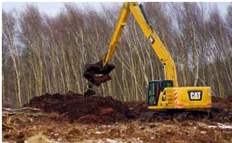
Mit langem Ausleger werden die Dämme zur Vernässung des Nienwohlder Moores aufgesetzt. Fotos: Klaus J. Harm
