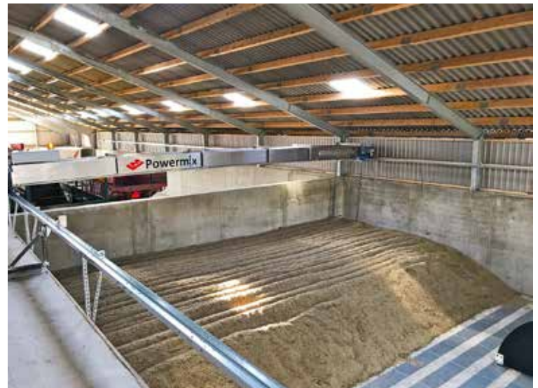
Schnelltrocknungszelle mit Mischtraverse
