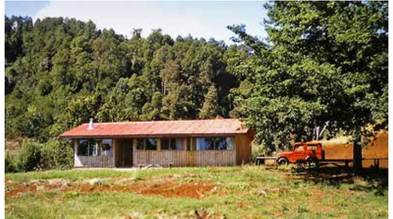
Das Holzhaus des Fundos 1982, wo die Aufforstung stattfinden sollte
